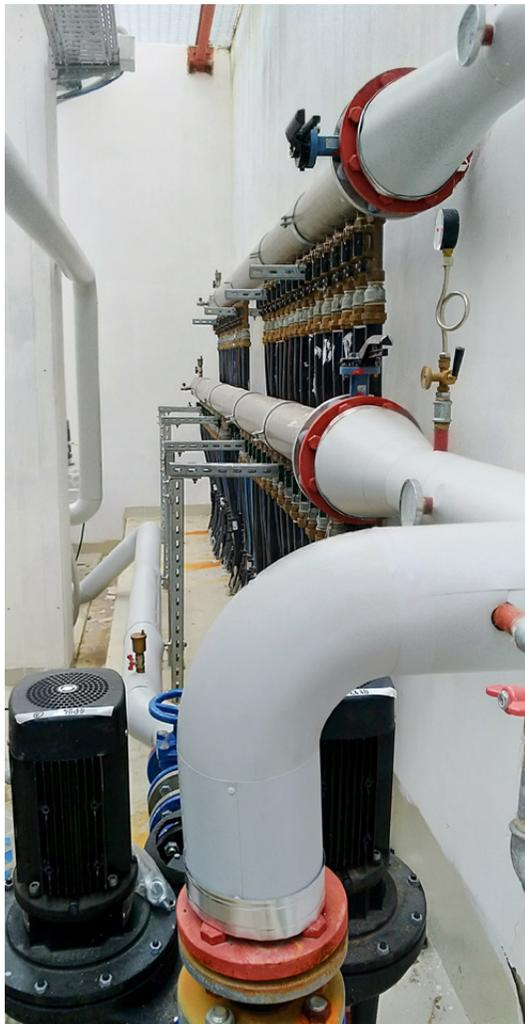
I collettori del campo geotermico forniscono acqua a temperatura costante per la copertura della quota base giornaliera per la climatizzazione, che incide per il 12% del fabbisogno totale annuo
