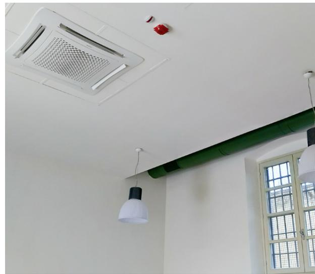
I ventilconvettori e la ventilazione ad aria primaria, supportata dai recuperatori di calore a flussi incrociati, provvedono alla climatizzazione della mensa e dell'area self service
