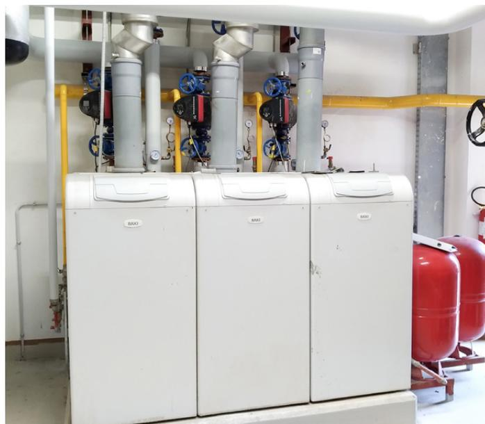
Le caldaie a condensazione intervengono per la copertura dei picchi della domanda termica, sia per mantenere alla temperatura operativa l'impianto dell'ACS
