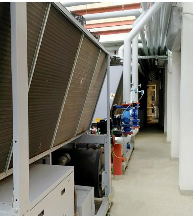
L'integrazione della domanda di fluido caldo è appannaggio di 2 pompe di calore aria/acqua, per la copertura preferenziale dei picchi di carico e per il preriscaldamento dell'ACS
