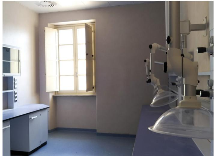
I laboratori della Polizia Scientifica sono equipaggiati prevalentemente con cappe a tutto ricircolo dell'aria, più alcune cappe a espulsione diretta, con funzionamento compensato per mantenere i locali in sotto-pressione
